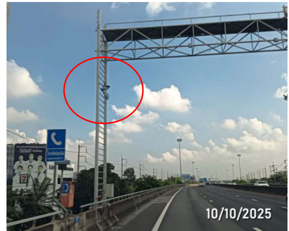
รูปที่ 3.2-14 กล้องโทรทัศน์วงจรปิด ตรวจจับรถวิ่งไหล่ทางพิเศษฉลองรัช
